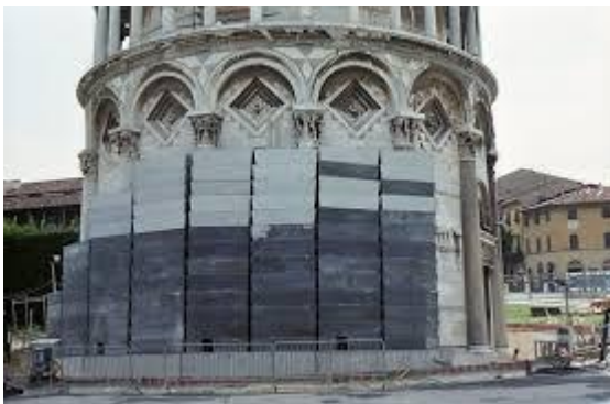
Contrappesi di piombo alla base della Torre
