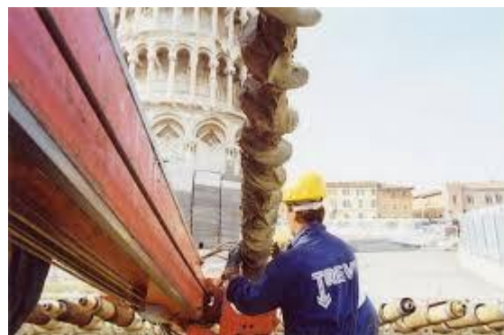
Trivellazioni alla base della Torre
